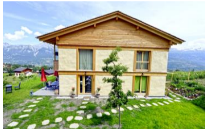
Des murs de paille couverts de chaux.
